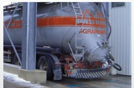
Ebenerdiger Einbau der WWS Plattformen für dynamisches Wiegen >>
